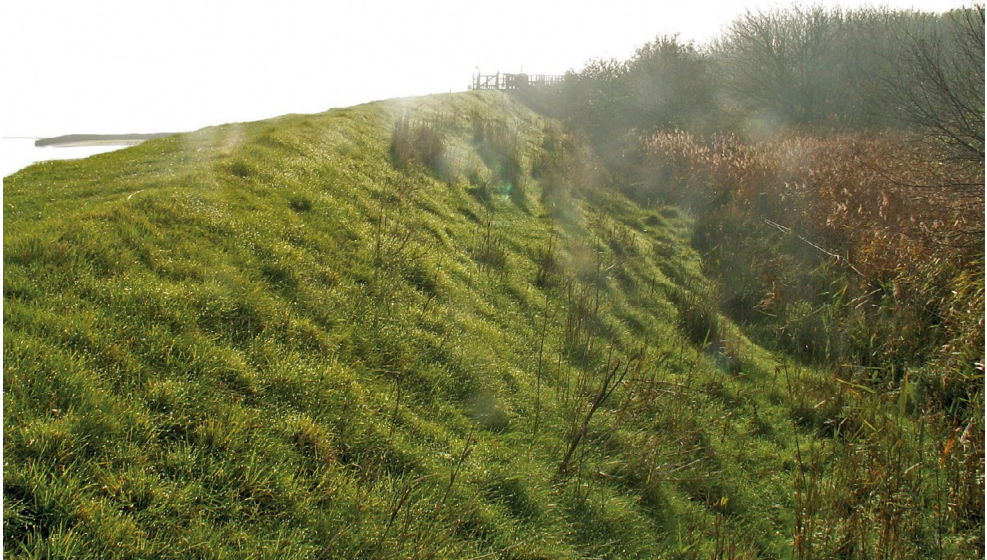
Abb. 4: Alter Deichabschnitt auf Sylt östlich der Kampener Vogelkoje mit Buckelwiesen-Strukturen und schwach durchsickerten Binsenfluren Foto: M. LÜDERITZ
